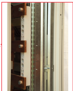
Gyűjtősin tartó rögzítése ASCLF200-ra
