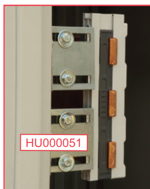
Gyűjtősíntartó rögzítés vázszerkezetre
