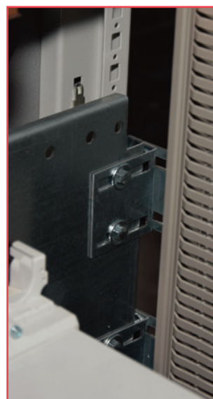
Szerelőlap rögzítés vázszerkezetre előlnézet
