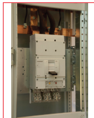
HU000049 vagy HU000050 szerelőlap előlnézet
